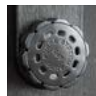
Valvola automatica di pressurizzazione
